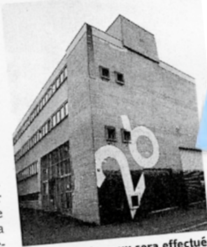
Le gros des travaux sera effectué cet été. (a)
